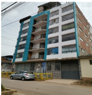
Edificio Multifamiliar. Cuzco
