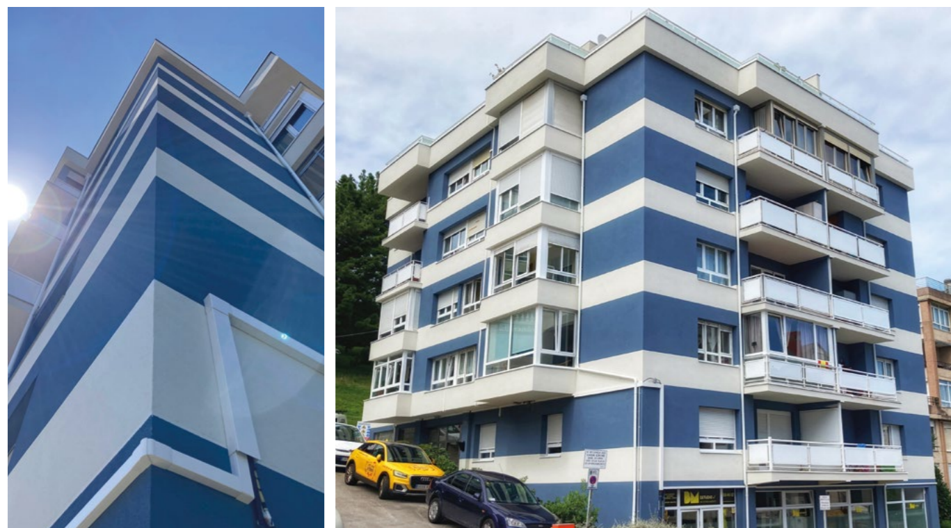
Proyecto: Alicia Villar / Ejecución: Arbone Rehabilitación
