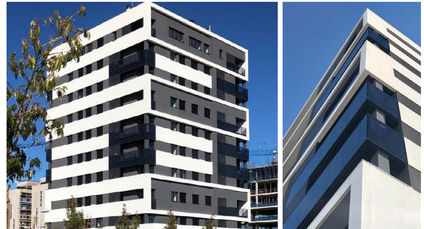
Promotora: HABITAT / Proyecto: CIP Arquitectos SL / Constructora: FATECSA / Aplicador: REVOTHERM Fotos: CIP Arquitectos SL
