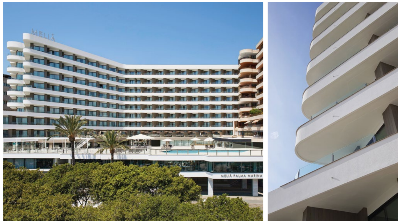
Proyecto: Alvaro Sans, ASAH / Constructora: S' Estel Construccions / Aplicación: Hormuk
