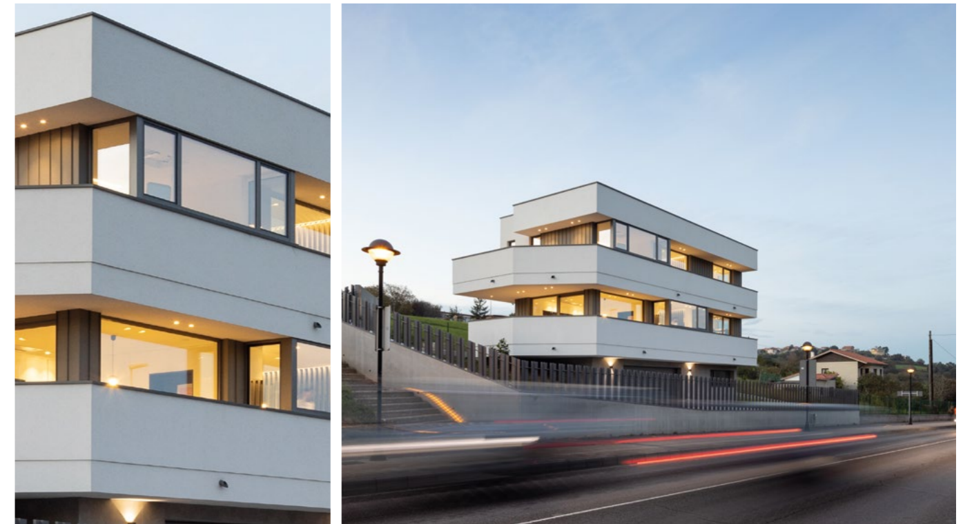
Proyecto: David Olmos Arquitectos / Constructora: Construcciones Santigoso, S.L. / Aplicador: Yesos Castrillón Fotos: ©Alexander Bogorodskiy
