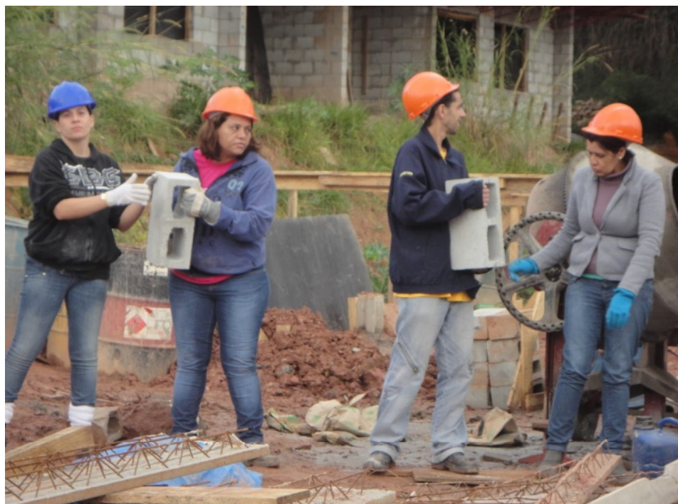
Figura 3: Trabalho mutirante em obra
