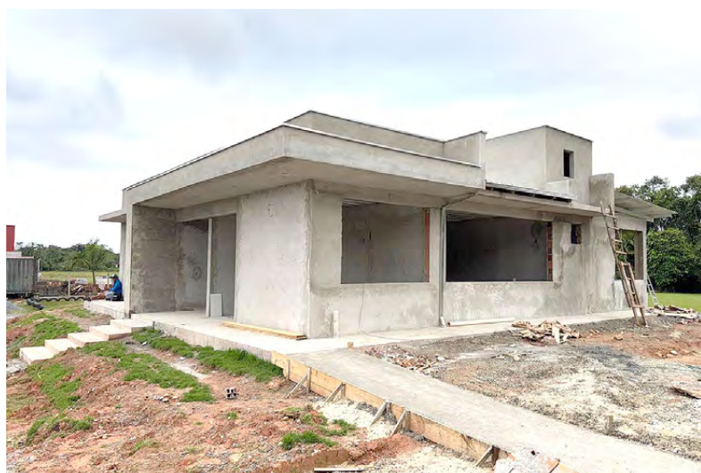
A construção da sede da Missão Morro do Meio (ILUOS), com recursos provenientes de doações, está em fase final
