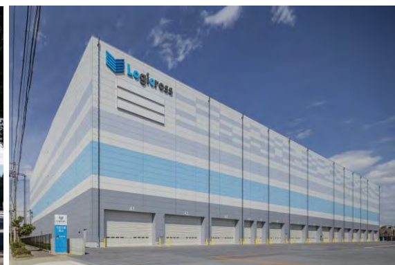
ロジクロス大阪住之江 2025年3月竣工
