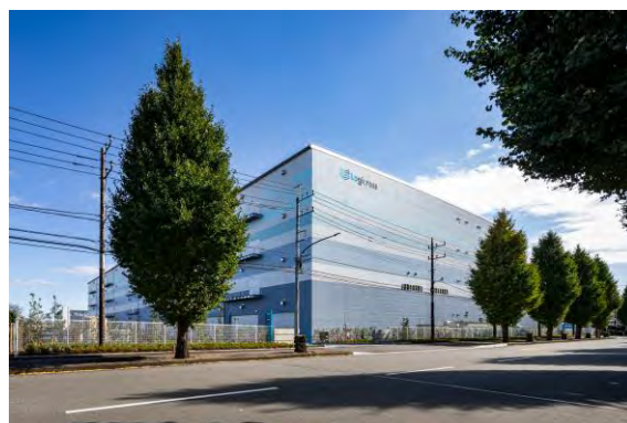
ロジクロス厚木Ⅲ 2024年11月竣工
